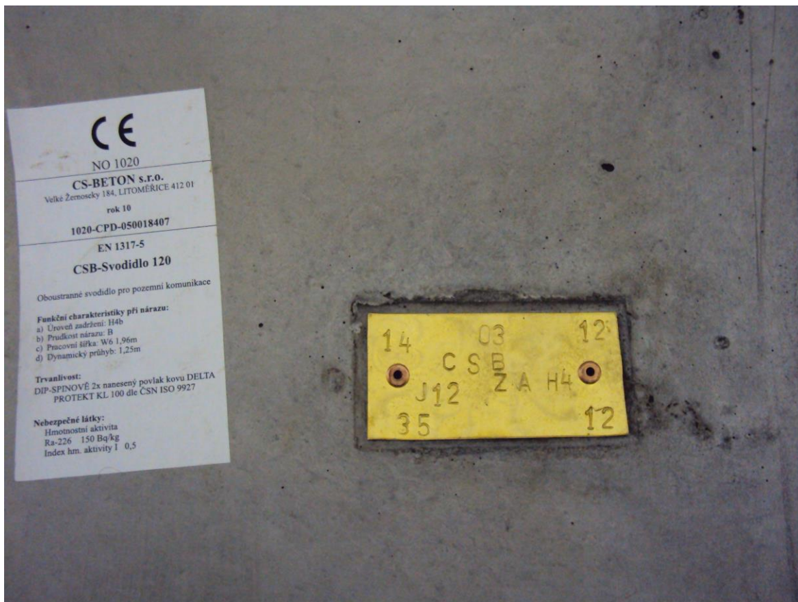
Obrázok 12 – CE štítek a mosadzný štítek značenia betónových zvodidiel CS-BETON
